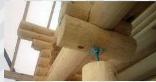
Шпилька Усиленная способна выдерживать повышенные статические и динамические нагрузки, и может быть использована для изготовления специального крепежа, например регулировочных анкеров для деревянного домостроения.
